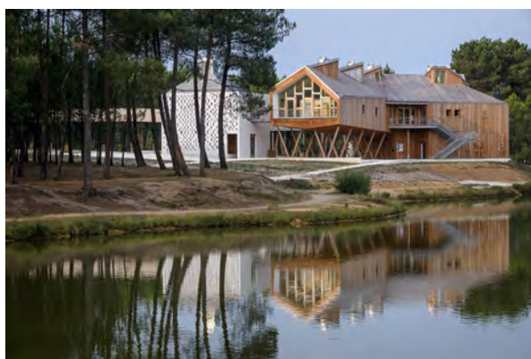
Lauréat équipement Parc Mysterra à Montendre Maître d'œuvre : (apm) associés, Bertrand Paulet paysagiste Maître d'ouvrage : Communauté de Communes de la Haute Saintonge
