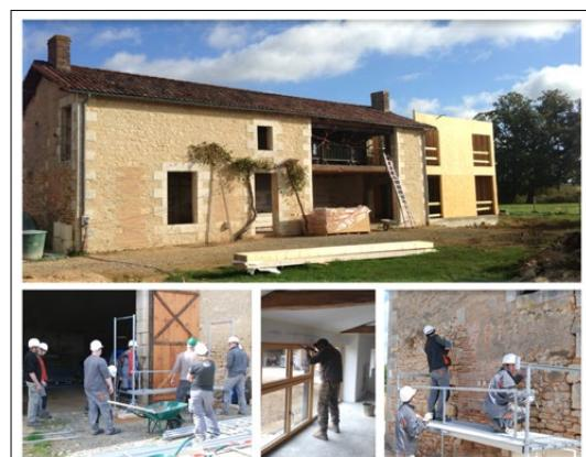
La transformation s'est faite en écoconstruction, avec des matériaux de proximité naturels : chaux, chanvre etc. On a utilisé une partie de la façade pour avoir un espace vitré qui chauffe le sol de la médiathèque et une double-flux qui répartit.
