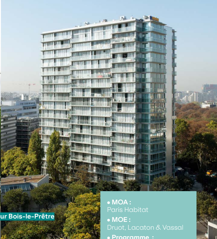
Nouvelle façade du Lurçat
