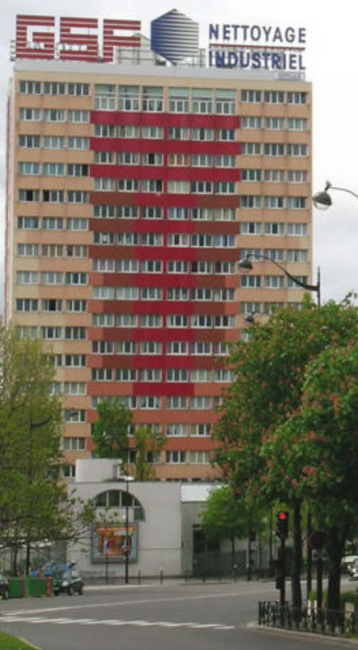
Nouvelle façade de la tour Bois-le-Prêtre
