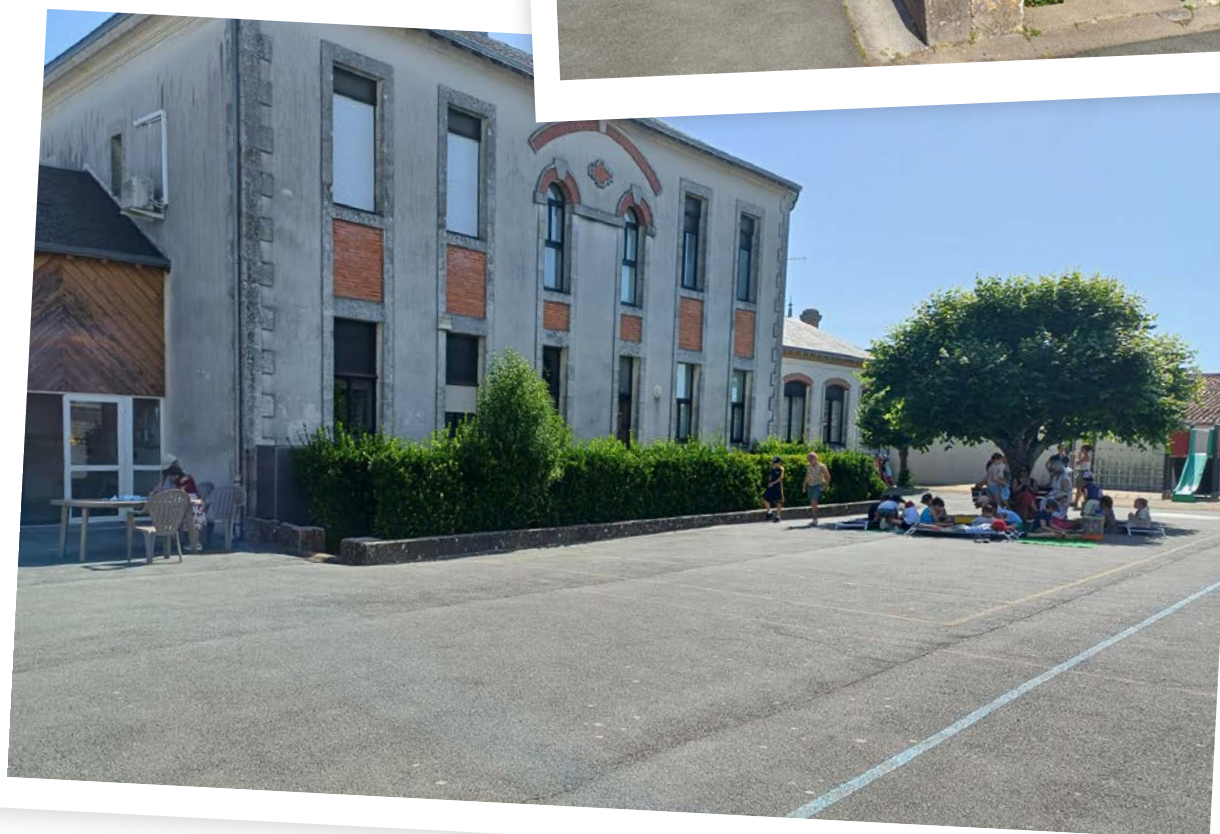
Arrière de la Mairie, donnant sur la cour enrobée et arbre comme seul point ombragé
