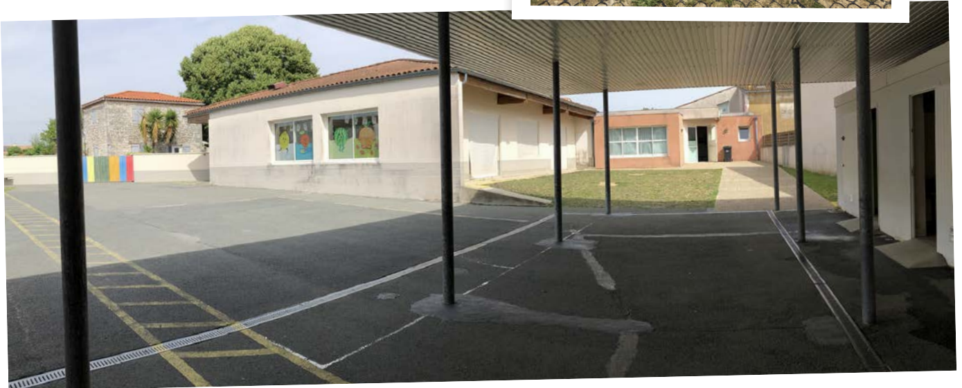
vue panoramique sur l'ensemble de la cour
