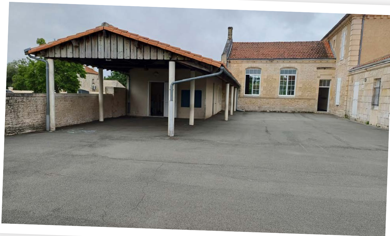
Partie est de la cour, la cantine se trouve au fond du préau.
