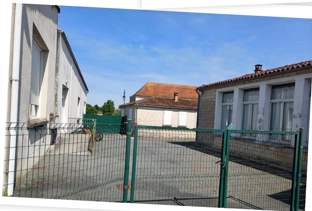
Espace intermédiaire inoccupé entre cour maternelle et cour élémentaire de Chérac
