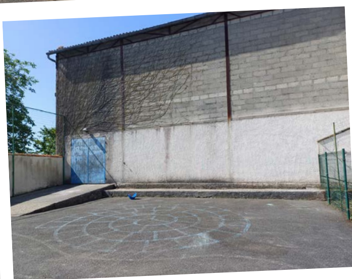
Rampe et marches en béton au pied de ce mur gris
